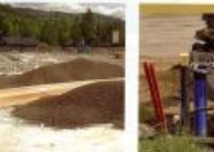
ENERGIBRINNE – Byggingen av kunstgresset på Vinstra er et samarbeid mellom kommunene Sar-Fron og Nord-Fron.
